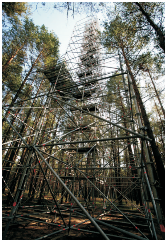
Ryc. 8. Ramowa konstrukcja wieży, ustawiona na podeście z żelbetowych płyt. (fot. P. Strzeliński)
