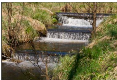
Ryc. 3. Kaskadowa zabudowa cieku a) Krępa – wylot ze zbiornika nr 2, b) Sinowa – wylot ze zbiornika nr 3 (fot. T. Dobek)
