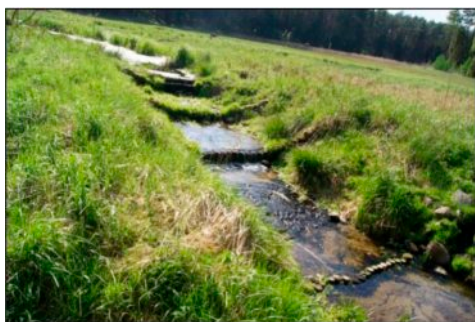
Ryc. 3. Kaskadowa zabudowa cieku a) Krępa – wylot ze zbiornika nr 2, b) Sinowa – wylot ze zbiornika nr 3 (fot. T. Dobek)
